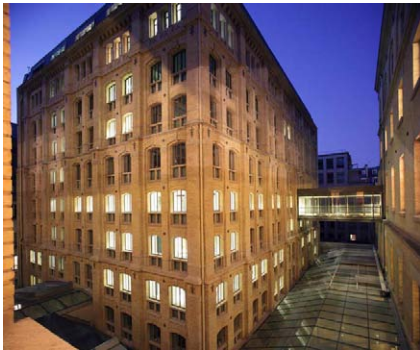
75001 Paris Ministère de l'Economie, des Finances et de l'Industrie / DPMA Réhabilitation totale de l'immeuble «Archives» de la Cour des Comptes
