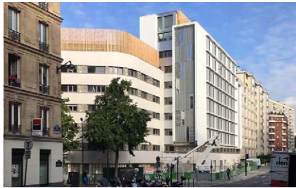
75013 Paris COALLIA Habitat Restructuration/extension d'une résidence sociale de 182 studios
