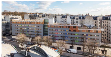
75020 Paris COALLIA Habitat Restructuration et extension d'un foyer en résidence sociale de 232 logements, construction d'un restau- rant associatif
